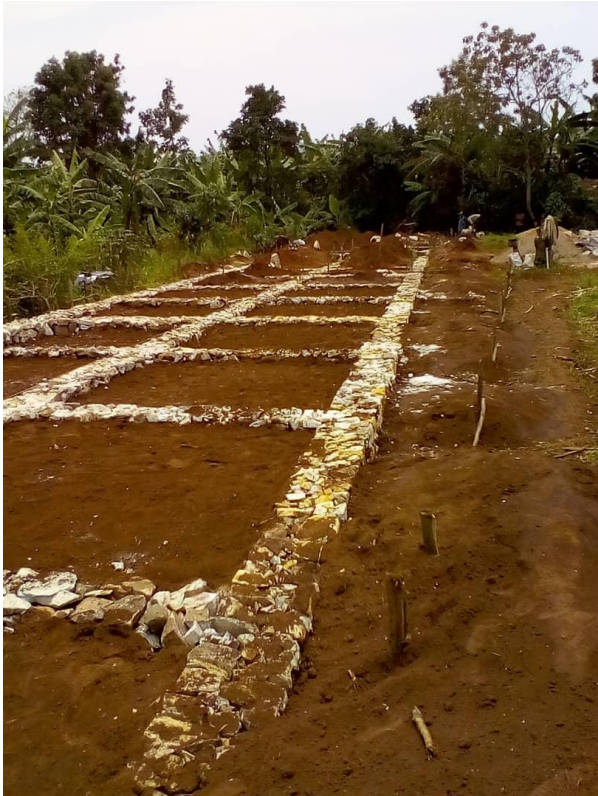
Het leggen van de funderingen in februari 2022
